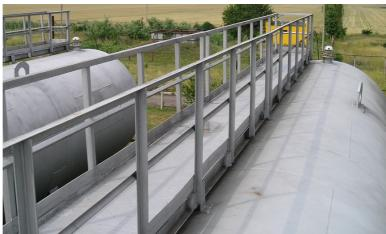
Блок измерительных преобразователей на газонаполнительной станции ОАО «Укргазсервис», Первомайская район, Николаевская область, монтируется непосредственно на резервуаре. Весь процесс монтажа сводится, по сути, к затяжке гаек между фланцами.
